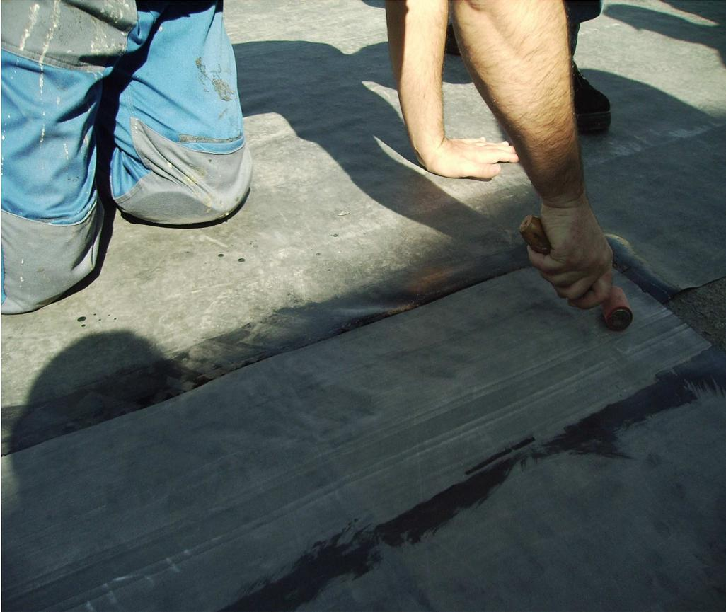
**5. COLOCACIÓN FLOTANTE.** (Se aconseja colocar la membrana EPDM de 1,14mm de espesor para colocación flotante). Garantías de 20 años en el material y 10 años en la aplicación
