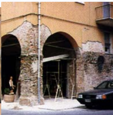
Demoler el revoque
