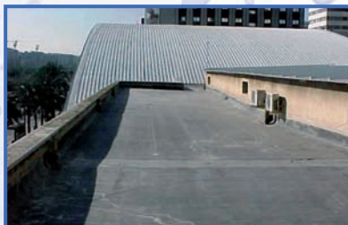
ESTACIÓN AUTOBUSES (VALENCIA)
