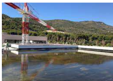
EPDM RESITRIX autoadhesivo. Prueba de estanqueidad
