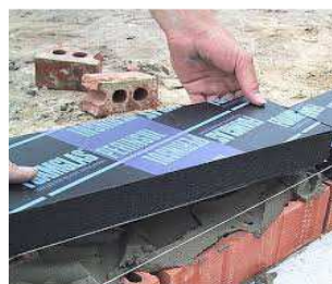
Aislamiento base muro Foamglas
