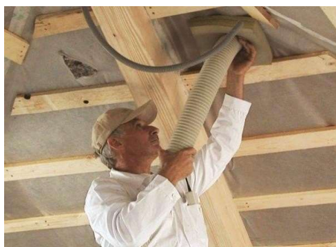
Figura 4: Aislamiento de celulosa en un tejado inclinado (a: parte posterior, b: parte superior)
