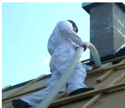
Figura 4: Aislamiento de celulosa en un tejado inclinado (a: parte posterior, b: parte superior)
