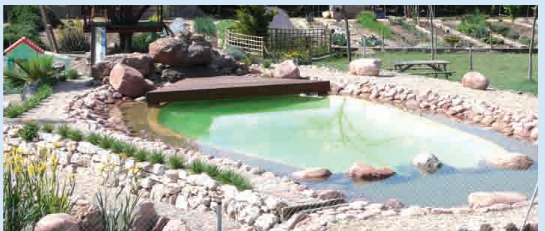
Piscina acabada sin necesidad de hormigón
