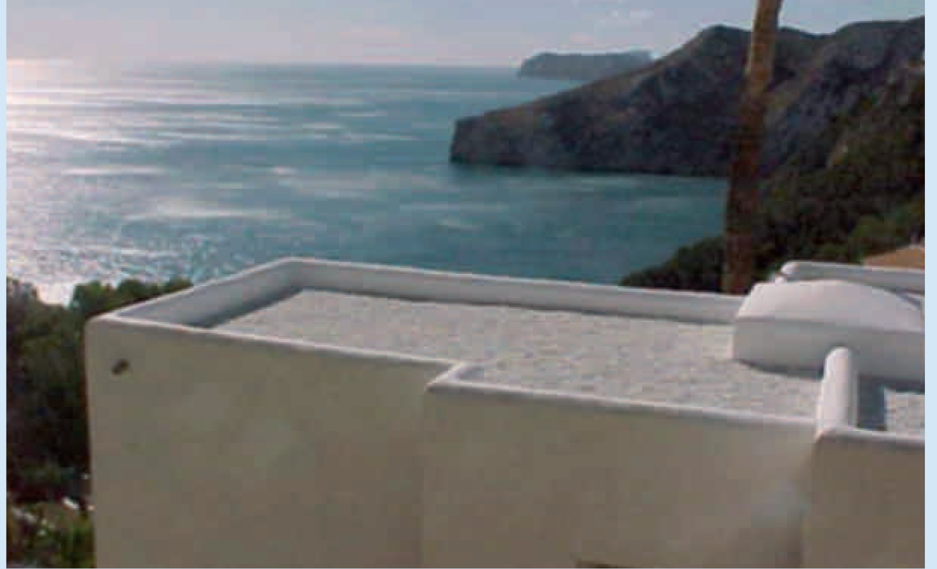
Cubierta invertida lastrada con grava
