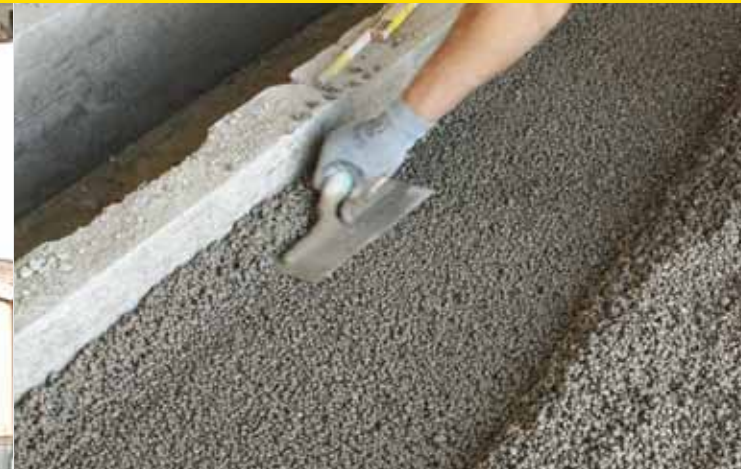
Rehabilitación palacio Malabaila - Asti - Italia
